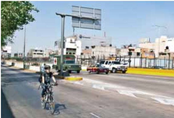
Via de acceso controlado.
